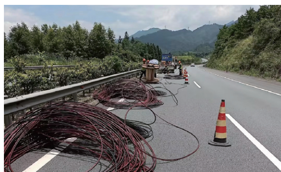
G.654.E光纜施工現場
